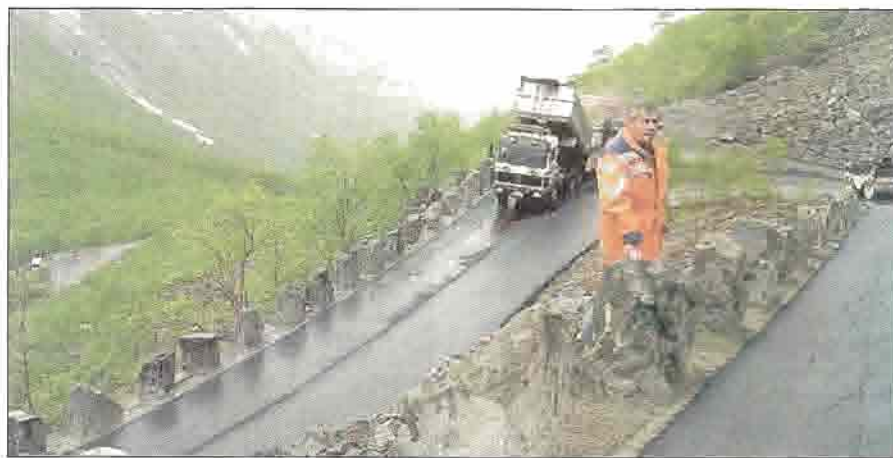
Et omfattende sikringsarbeid er gjennomført i Trollstigen etter raset i april måned. Når alle de innpå 145 veteranbilene skal pese seg opp stigningene neste år, skal alt være klappet og klart.
