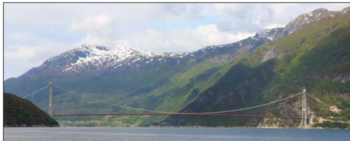
Hardangerbrua åpnet i august og er 1380 meter lang og har seilingshøyde på 55 meter. Den går mellom Vallavik i Ulvik og Bu i Ullensvang kommune.
