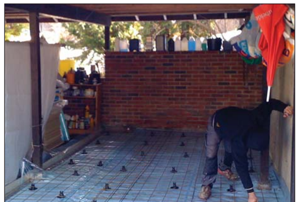
Garasjegulvet gjøres klart til støping.
